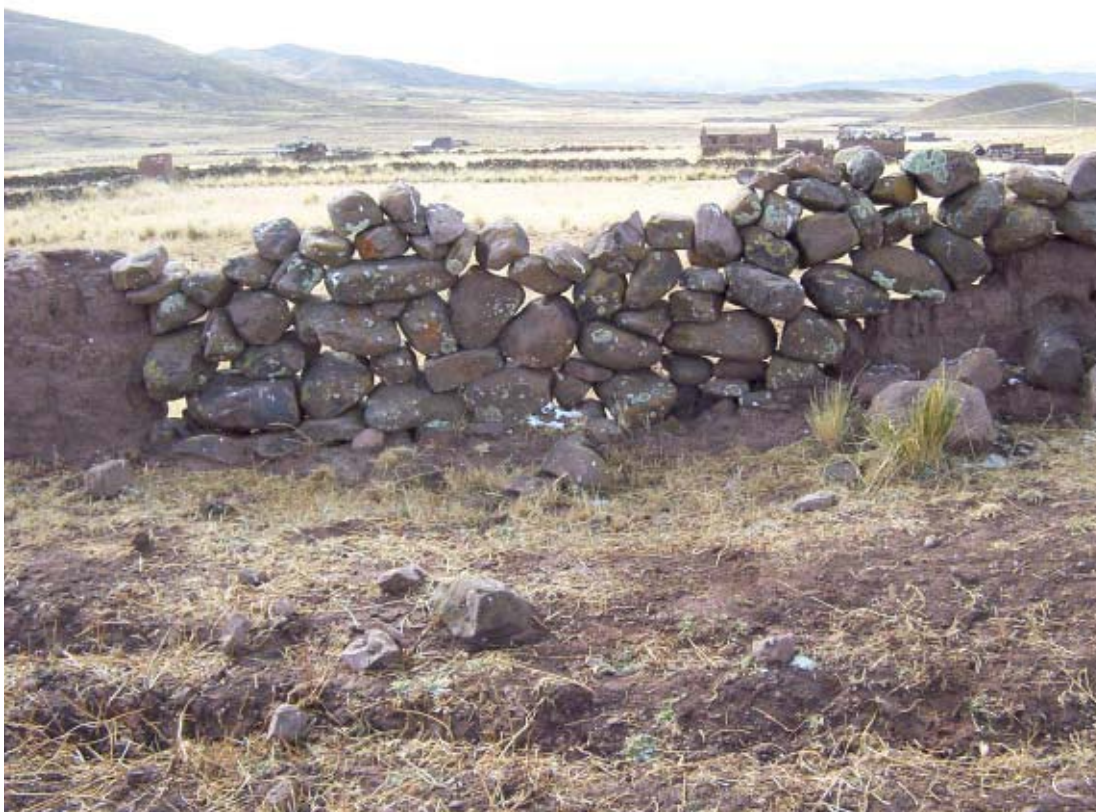
Figura 1: La puerta de la iglesia colonial (llenado con piedras), mostrando los adobes existentes del muro.
